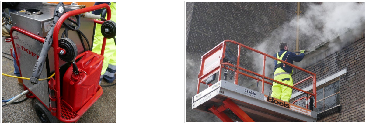
Figuur 5: Proef met stoomreininging(Doff) bij Markthal (uitvoering Stonehealth Ltd)
