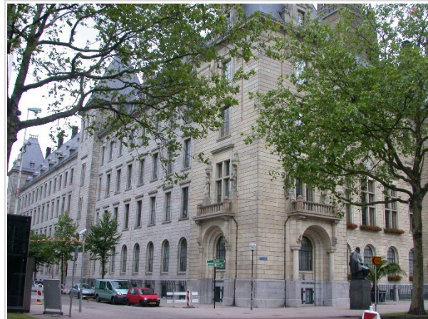
Figuur 17: Gevels van het stadhuis in Rotterdam, de voorgevel (rechts) gereinigd met laser is wat geler dan de zijgevel die is gereinigd met een straaltechniek (foto 2009).
