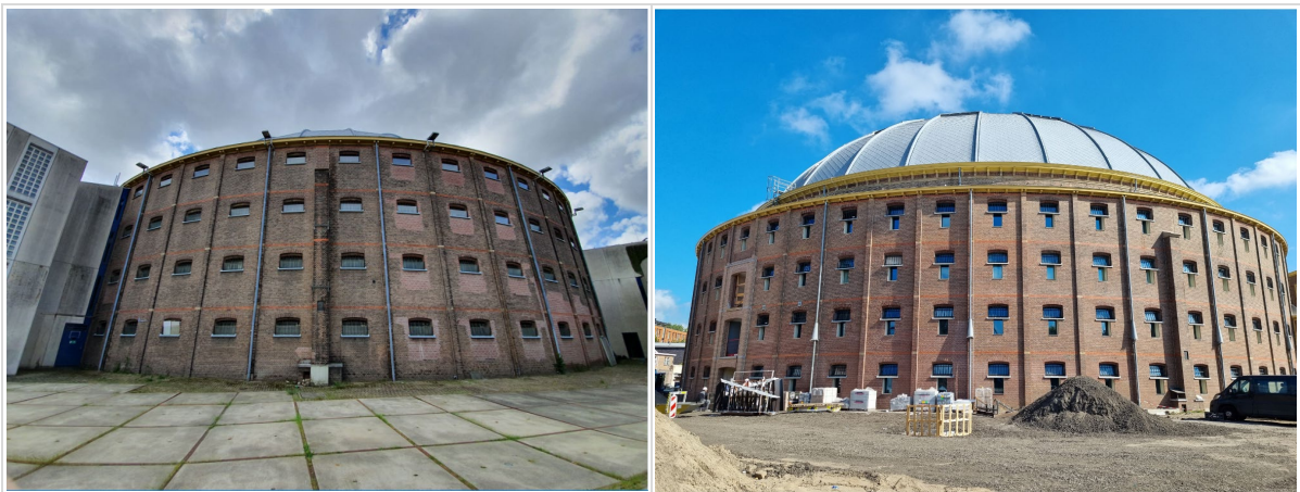
Figuur 2: Herbestemde en gerestaureerde koepelgevangenis in Haarlem, voor en na reinigen en retoucheren. Foto's: Buro van Stigt, (uitvoering Superlook).
