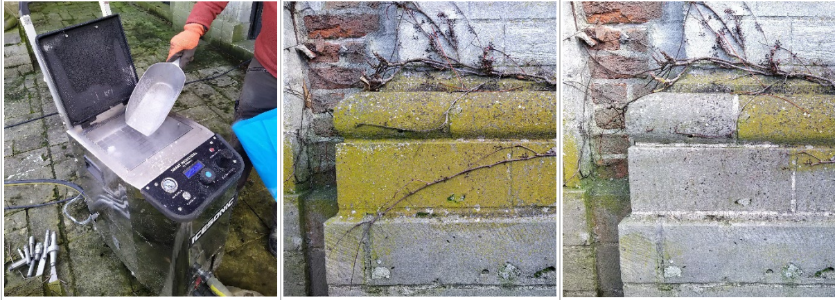
Figuur 10: Straalmachine vullen met droogijs; Natuursteen sokkel met klimoprestanten; sokkel na reinigen met droogijs. Foto's Yves vanhellemont (WTCB)
