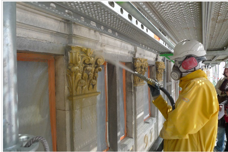
Figuur 7. Hydropneumatisch stralen van een natuurstenen gevel. Foto: Yves Vanhellemont (WTCB)
