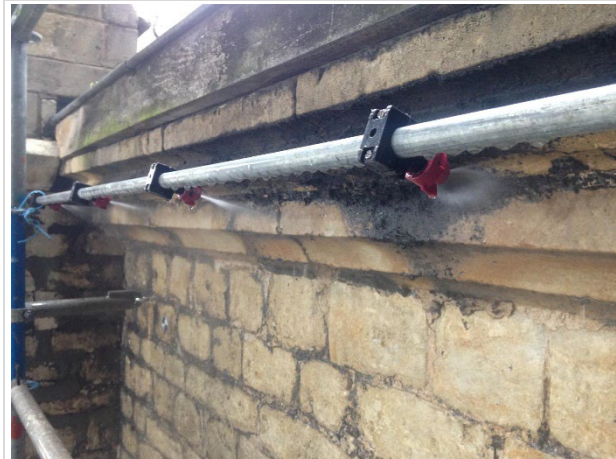
Figuur 4: Waterverneveling om gipskorst te verwijderen, foto: Yves Vanhellemont (WTCB)
