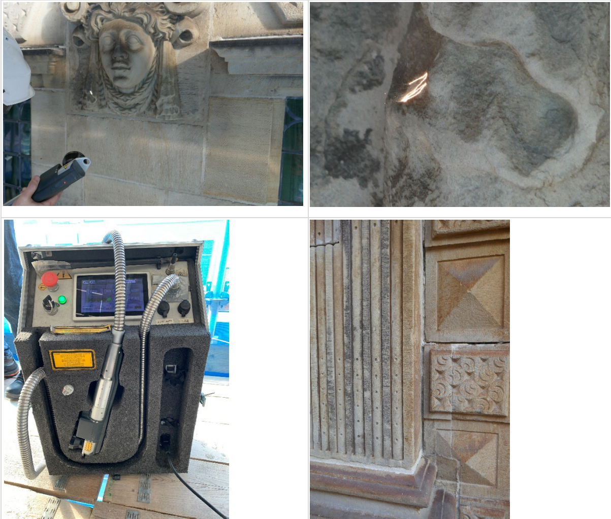
Figuur 16: Laserreiniging bij het Stadhuis in Leiden. Tijdens reinigen, laserapparatuur en na reiniging (rechtsonder). (uitvoering Venema Restauratie)
