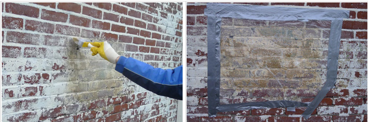
Figuur 14: opzetten en vervolgens afdekken met plasticfolie van verfabijt voor proef om verf te verwijderen. (uitvoering Ervas)
