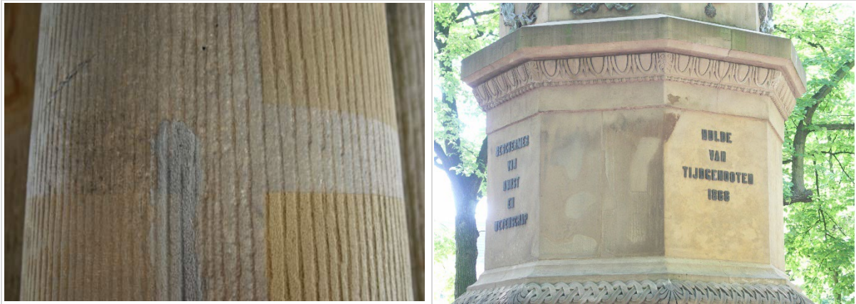
Figuur 20: Zandsteen die is bijgekleurd met een niet-dekkende gespoten laag minerale verf in zandsteenkleur.
