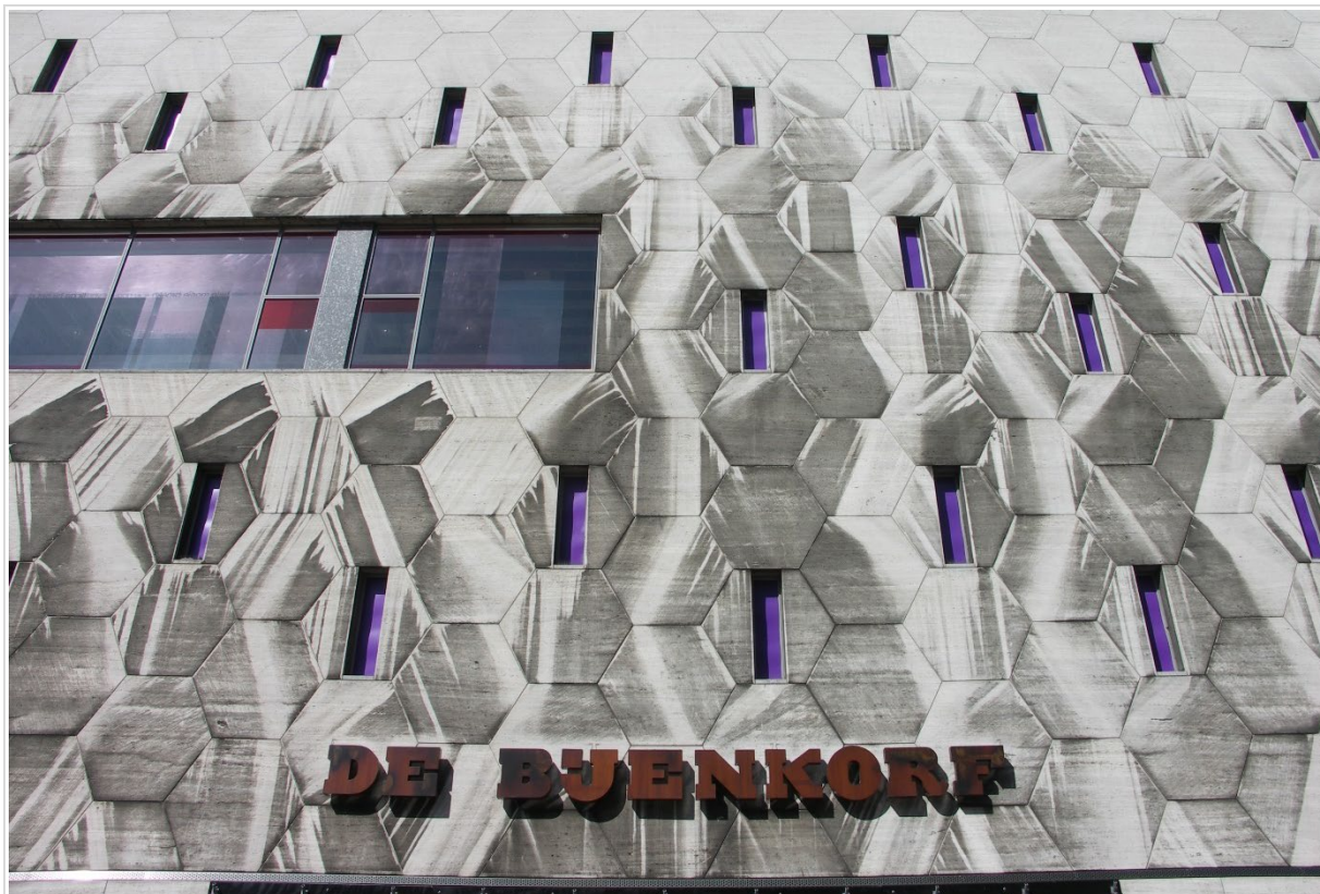
Figuur 23. Gevel van de Bijenkorf in Rotterdam. Door de wisselende richting van de machinale frijnslag op de travertijntegels ontstaat bij veroudering een bijzonder vervuilingpatroon. De architect schijnt dit bewust te hebben gedaan 15
